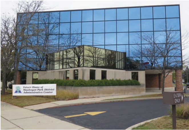
El viejo edificio de Waukegan Savings Bank se convertirá en el nuevo edificio de la administración del Distrito.
