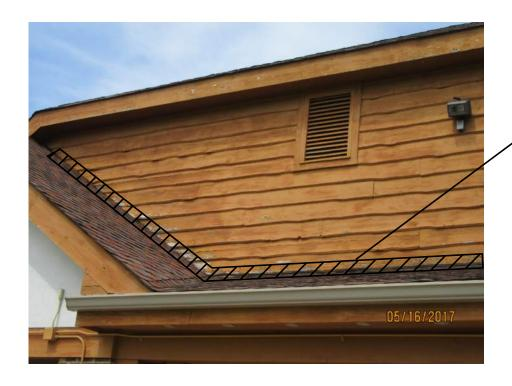
IN THIS LOCATION ONLY, CUT BOTTOM OF SIDING TO BE 1 1/2 INCH ABOVE SHINGLES USING STANDARD TECHNIQUE TO ACHIEVE DRIP EDGE ON CUT LINE
